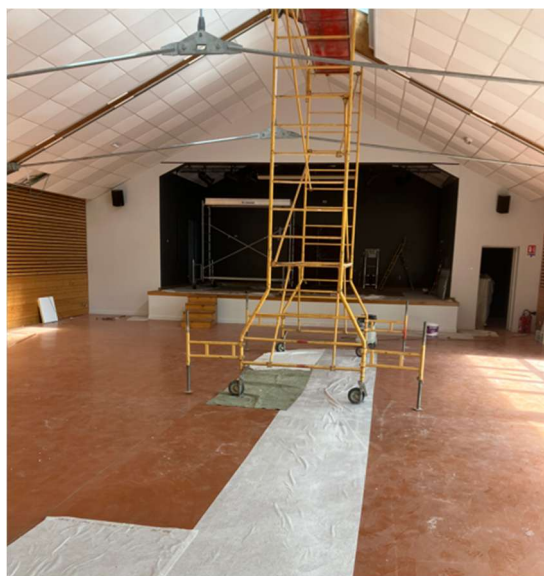
Travaux Maison des Associations
