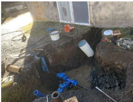
Travaux à Bughes
